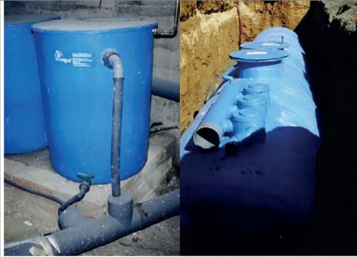
*Figura 7. Izquierda: depuradora de aguas grises de 500 litros de capacidad en el sótano de la vivienda. Derecha: depósito de recogida de aguas grises y pluviales (Fuente: Ecoaigua/Vivanco, 2004).*
